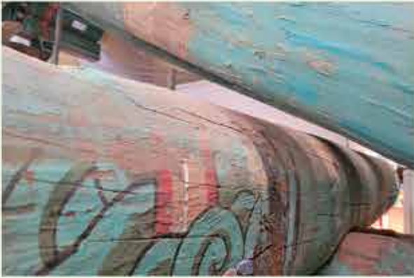
직재 장연 설치 시 주심도리에서 이격 모습
