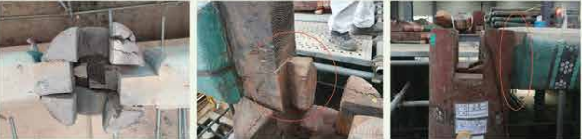
배면 좌측 창방 결구 현황 주막장부가 짧아 결구가 안되는 모습
